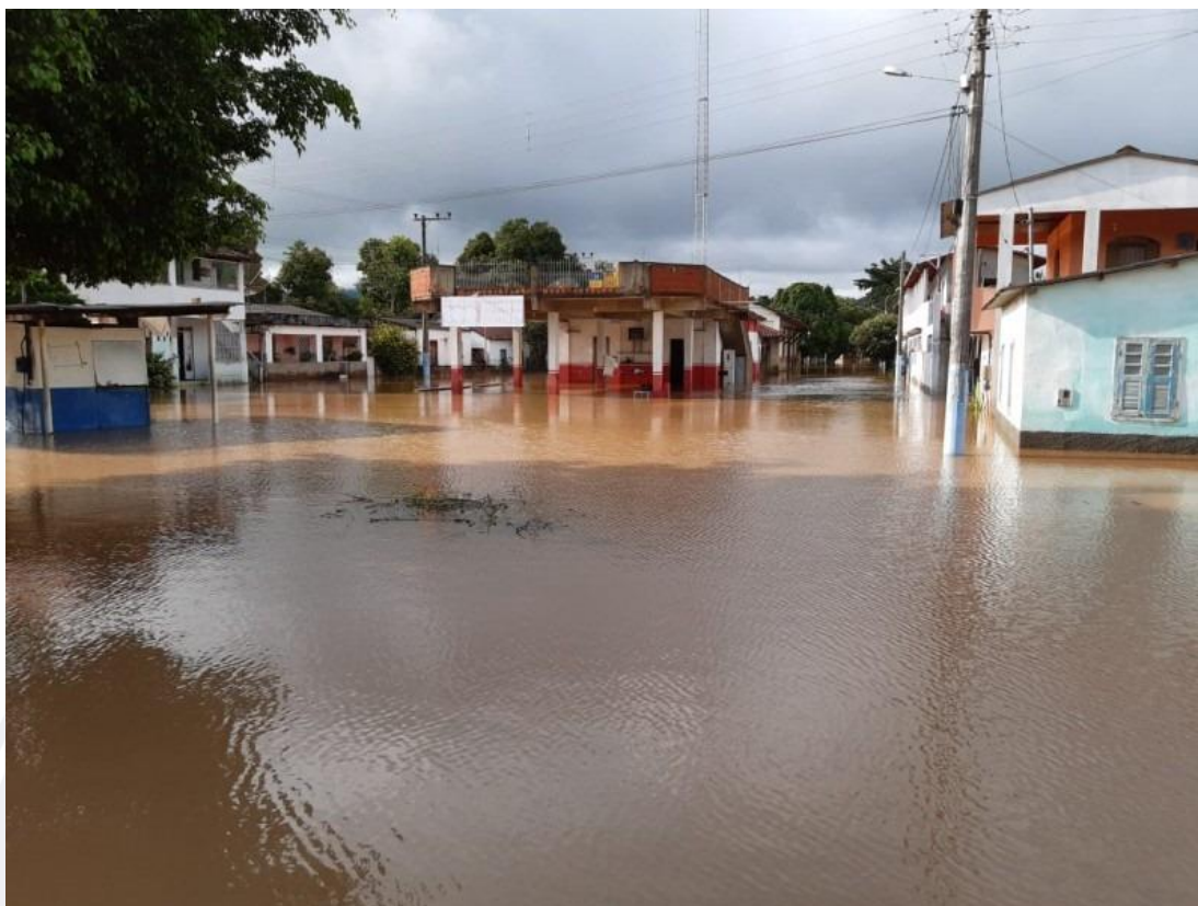
Figura 4. Praça Sebastiana Carvalho, José Carlos. Manhã após desastre, onde a água já havia abaixado aproximadamente 1,5m.
