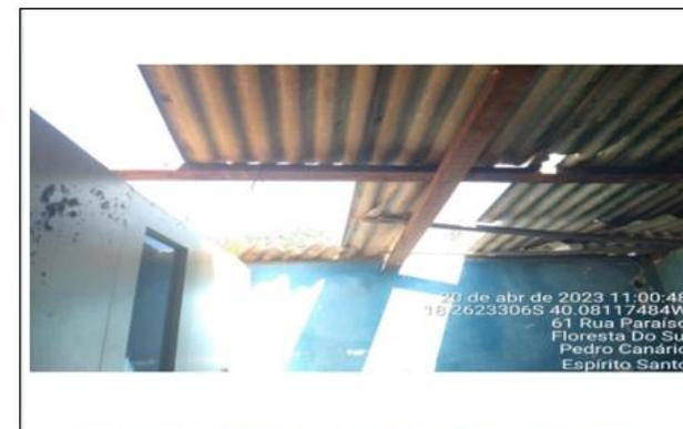
Figura 1 - [Descrição dos danos] [Ex: Telhas danificadas em virtude do vendaval]
