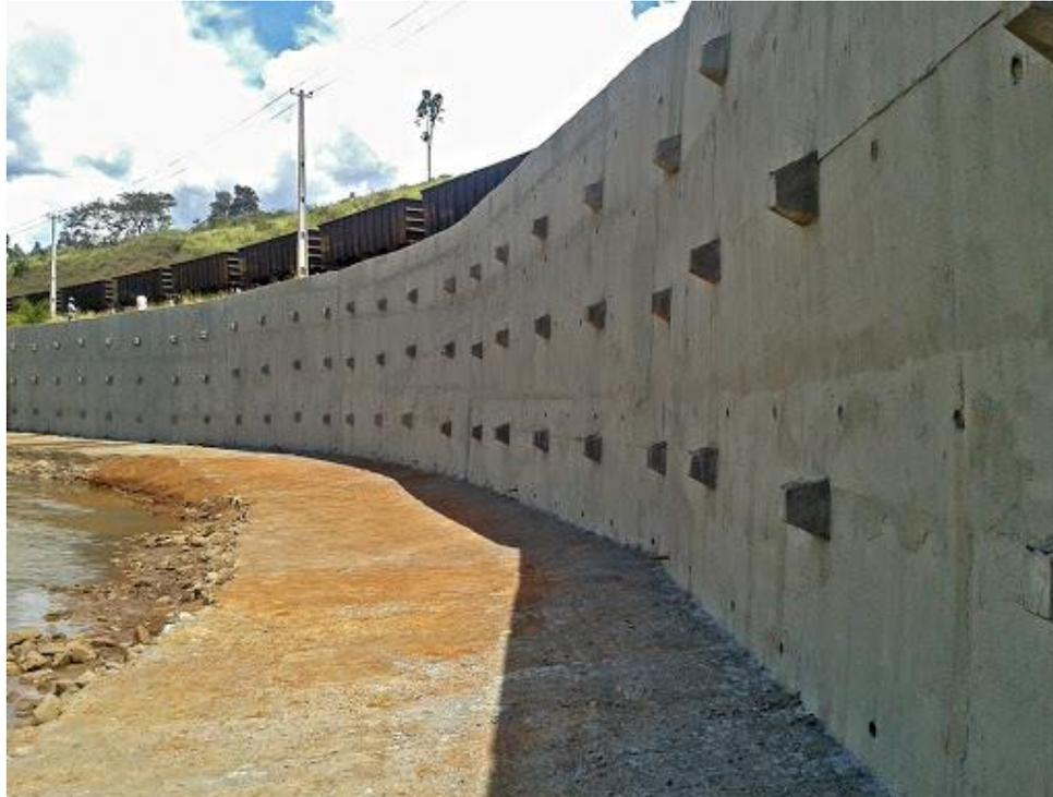
Cortina Atirantada e perfil esquemático.
