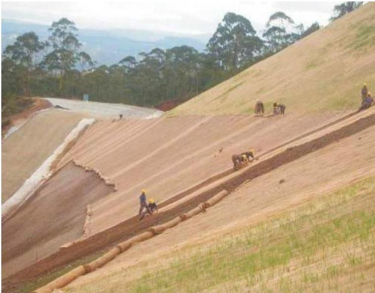
Aplicação das biomantas em talude de corte
