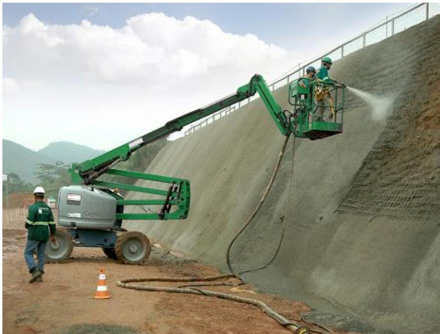
Talude de Contenção Concreto Projetado.
