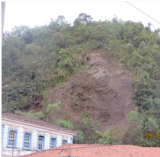
Deslizamento Planar Ouro Preto - MG
