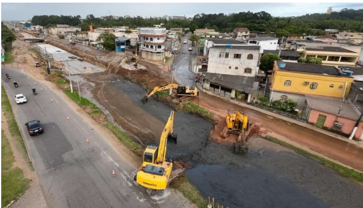
Foto 7: Obras de macrodrenagem no Rio Marinho. Crédito: Comunicação/PMVV.
