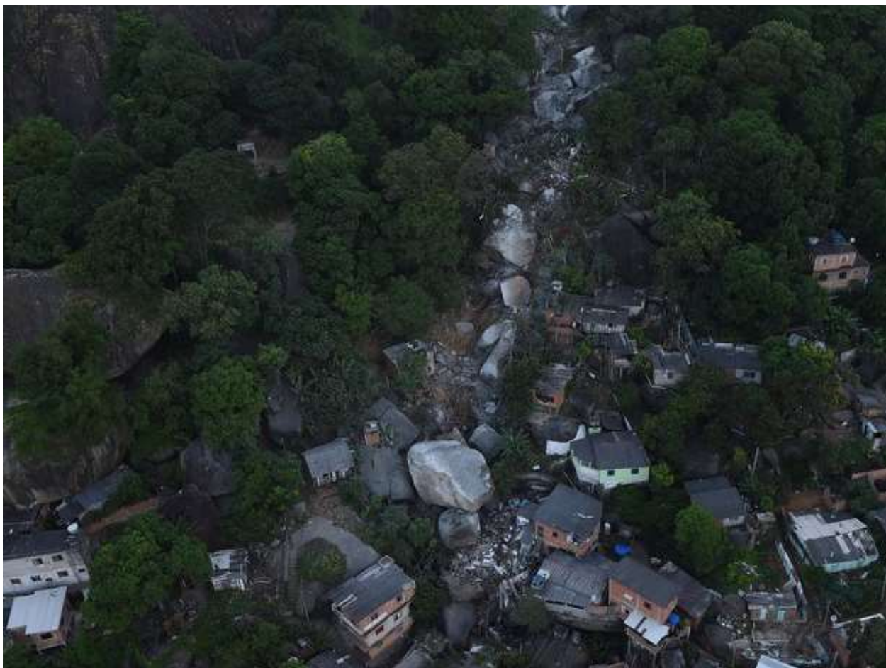
Foto 13: Deslizamento de rocha. Morro Boa Vista – São Torquato – 2016. Crédito: Fred Loureiro.
