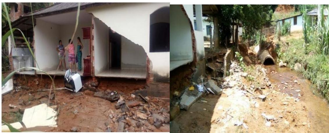
**Após uma chuva forte, as manilhas não suportaram a vazão que ocorreu, com a correnteza forte carregando parte de uma construção, na cabeceira Santa Marta, no ano de 2018.**
