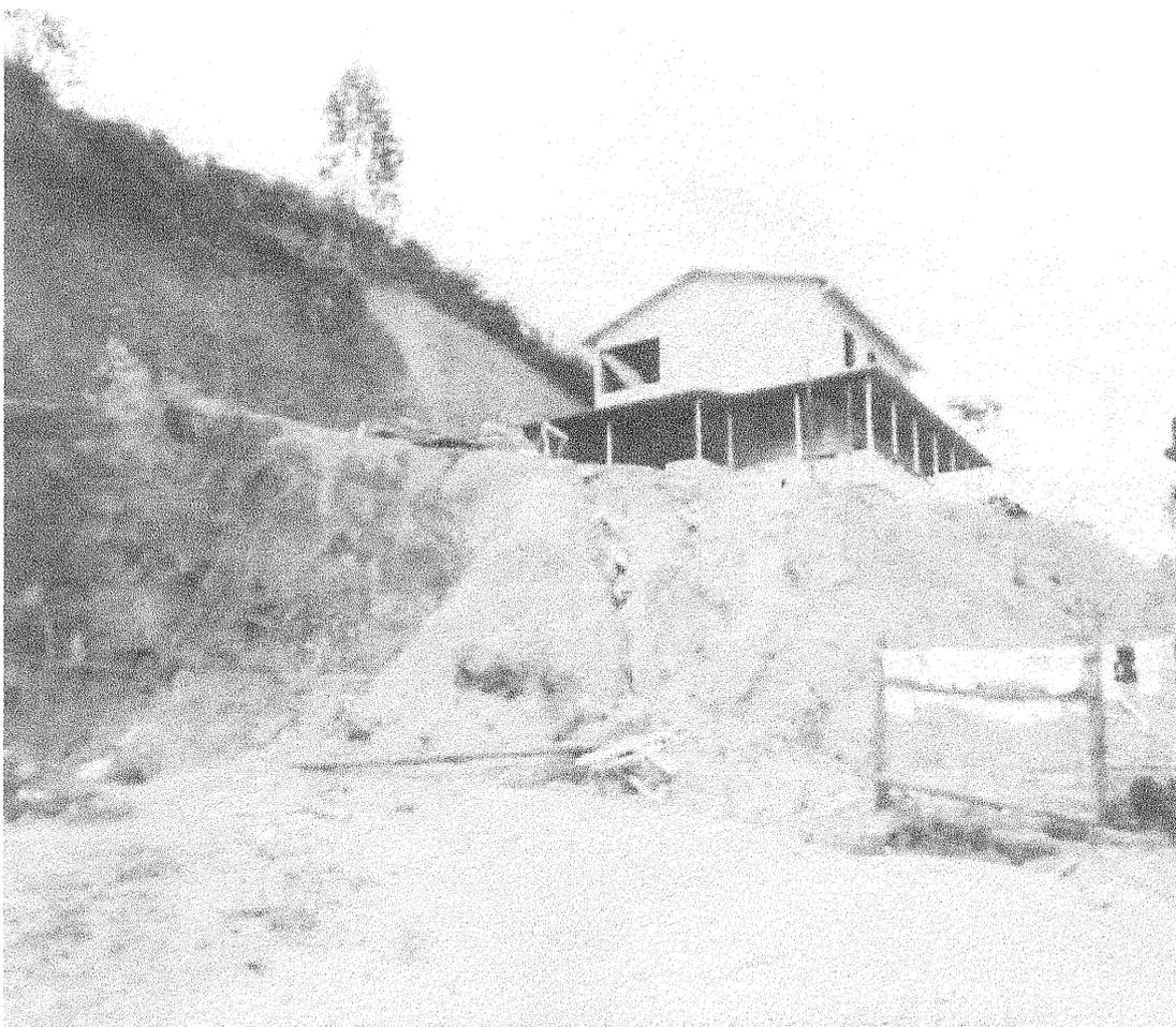
**Foto 4:** Imóvel em construção em corte e aterro.
