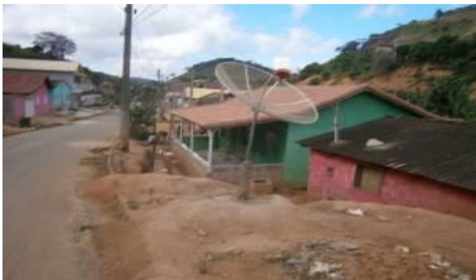
Foto 2 - Moradias situadas muito próximas à base de taludes de corte. Ausência de sistema de drenagem pluvial na rua do setor.
