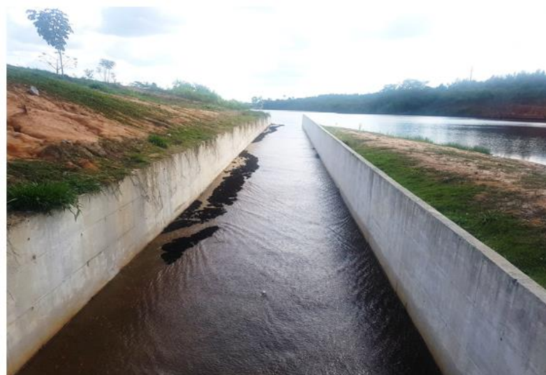
3. Vertedouro sem obstrução.
