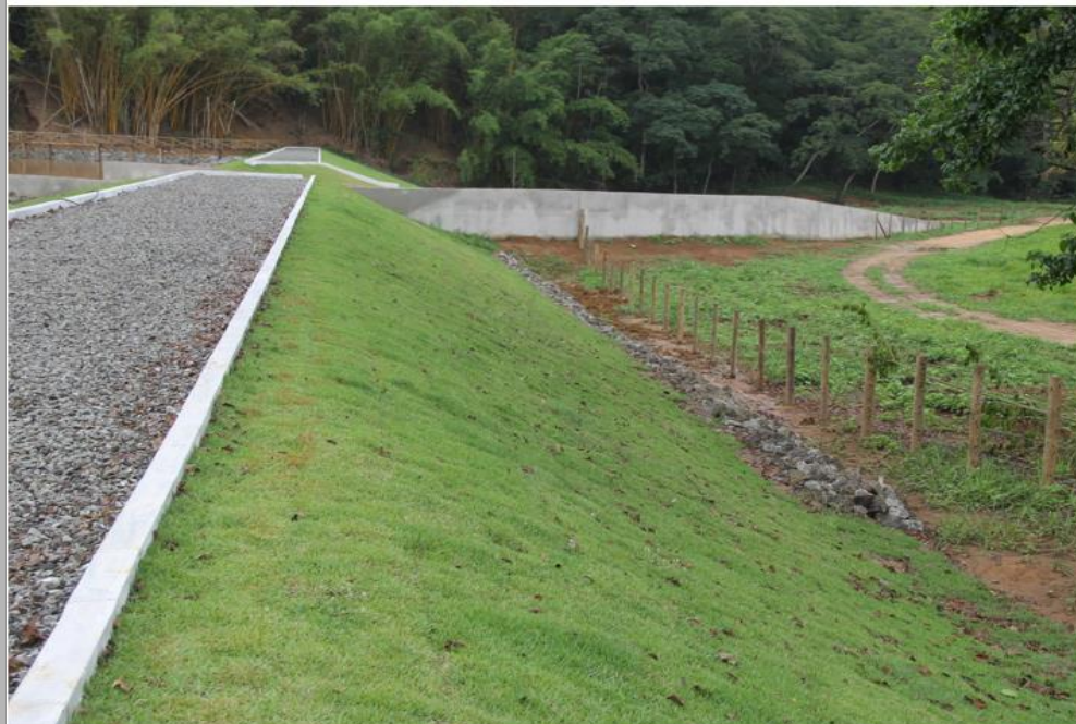
1. Talude de jusante com proteção adequada.
