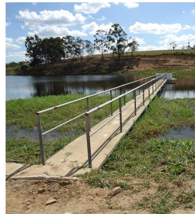
4. Monge com acesso adequado.
