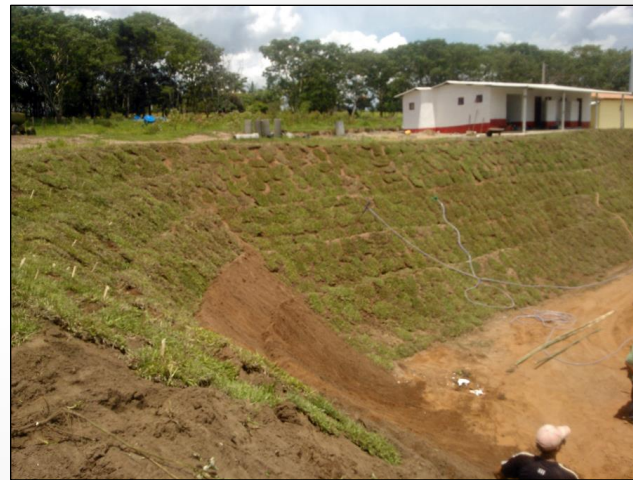
Proteção da face do talude com gramíneas.
