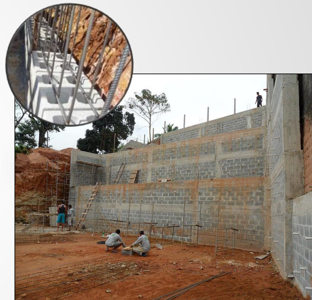
Fonte: projetos.habitissimo.com.br Muro de arrimo
