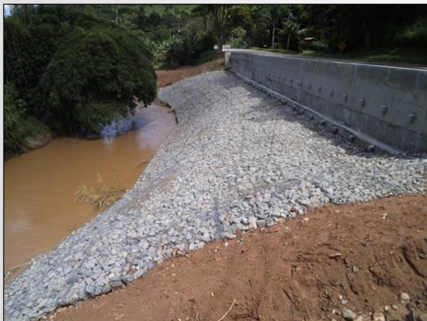
Créditos: SOPE Engenharia Enrocamento contra erosão
