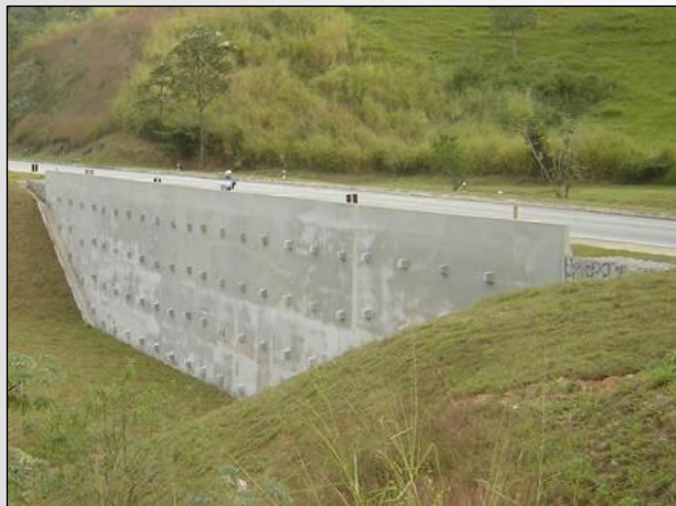
Créditos: SOPE Engenharia Cortina atirantada
