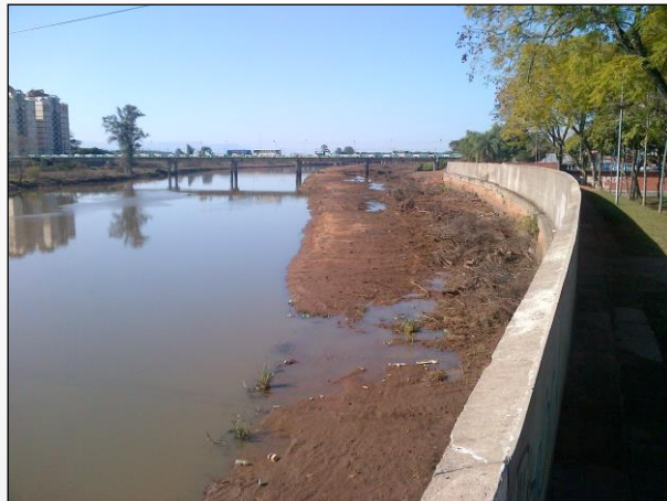
Fonte: < https://semgravata.wordpress.com > Dique marginal, São Leopoldo – RS.
