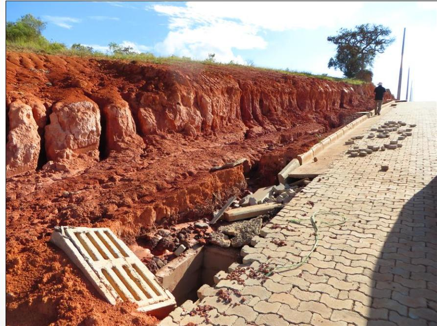
Erosão em via pavimentada, Ouro Preto – MG. Créditos: Júlio Lana, CPRM/SBG
