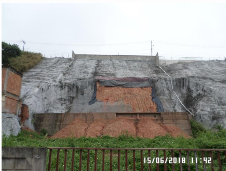
Estabilização de talude c/Geomanta Zona Rural de Marataízes/ES – Maio/2017
