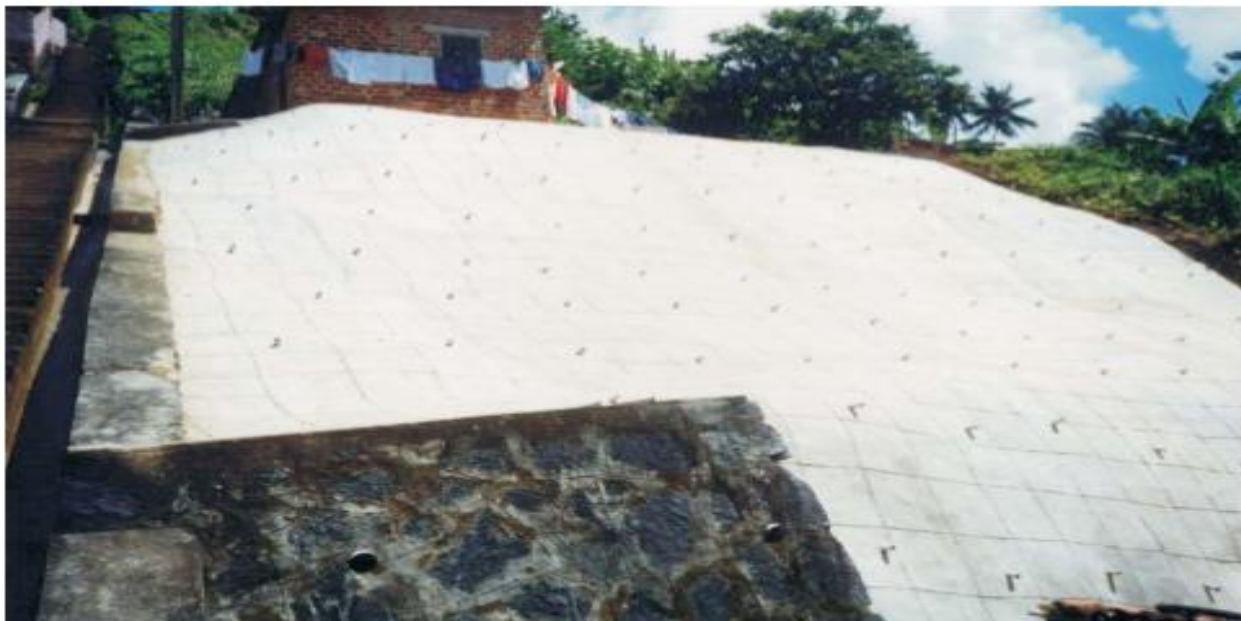
REVESTIMENTO COM TELA ARGAMASSA Camaragibe
