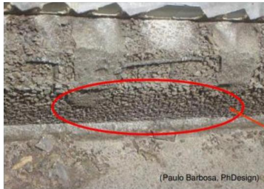
Remoção da pasta e exposição dos agregados
