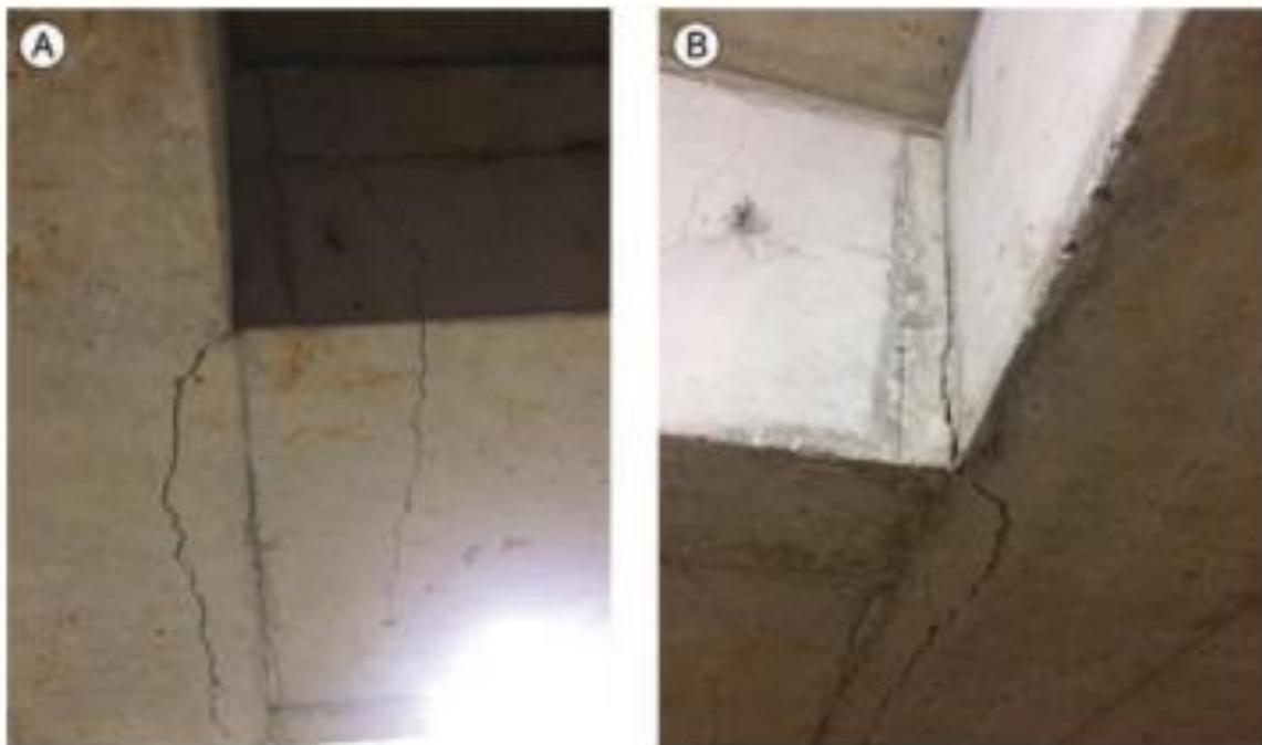
**Figura 37** – Fissuras importantes nos encontros de (A) viga com pilar e (B) viga com viga, decorrentes de projeto inadequado de estribos ou armaduras de suspensão, falhas de montagem das armaduras e/ou carregamento precoce da estrutura
